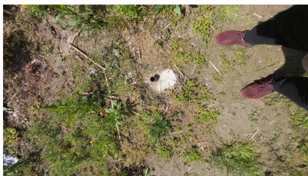
Бетонска стопа, са пресеченом цеви, где је била табла
